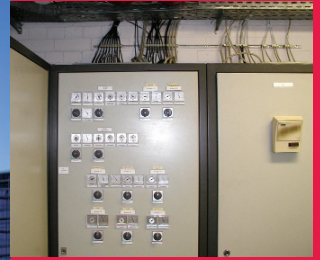
Austausch der pneumatischen gegen elektronische Lüftungssteuerung im SG
