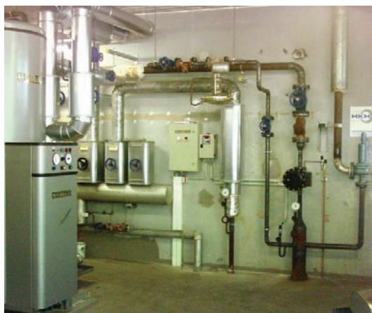
Optimierungsanlage Dampfkessel
