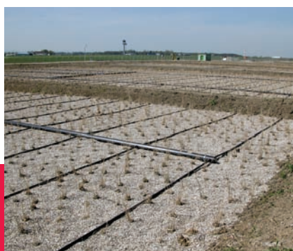
Bodenfilteranlage
