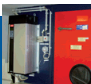
Frequenzregler Anlage für die Küche
