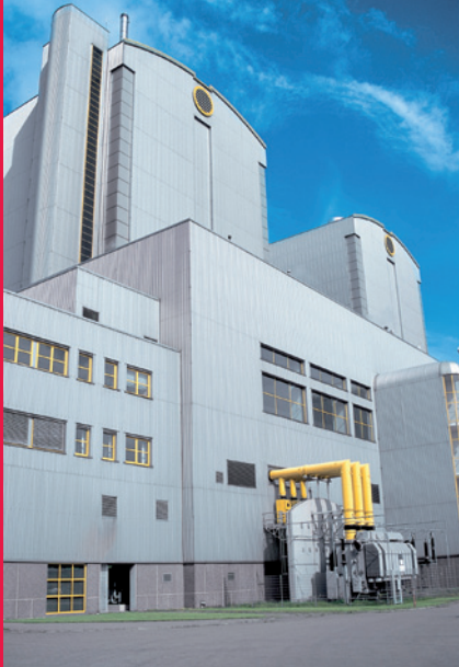
Das Heizkraftwerk Stöcken liefert Strom und Fernwärme für Hannover sowie Prozess- und Raumwärme für Volkswagen und Continental nach dem Prinzip der Kraft-Wärme-Kopplung
