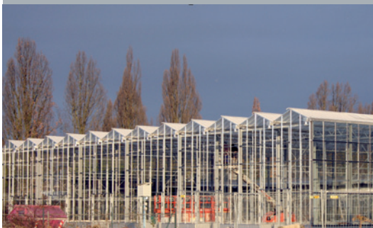
Neubau von Gewächshäusern
