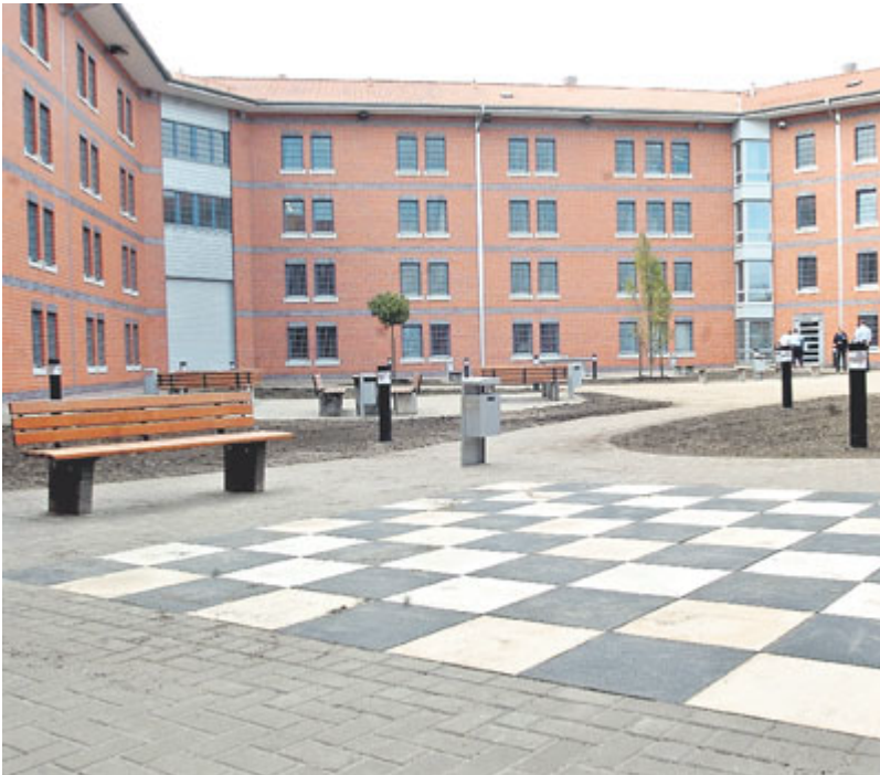
Platz drei für die JVA in Sehnde: Die Wäscherei arbeitet jetzt mit Wasseraufbereitung.
